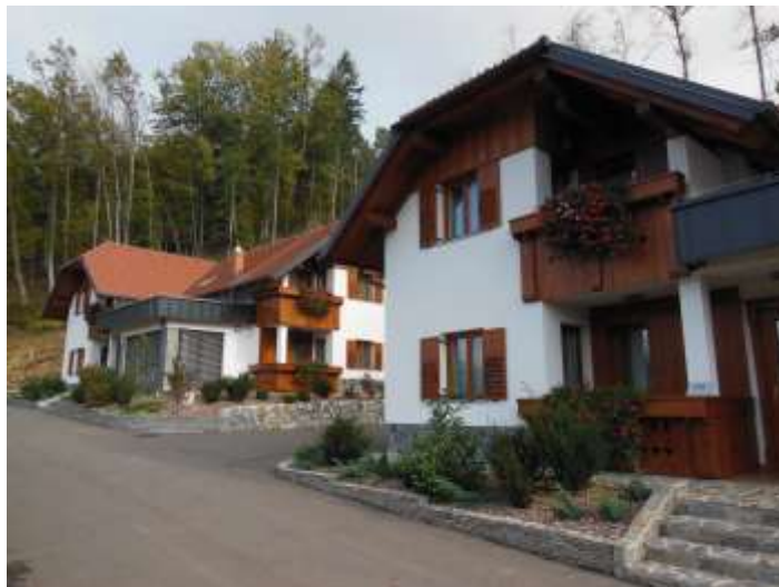
Beide Wohnungen in der Anlage
