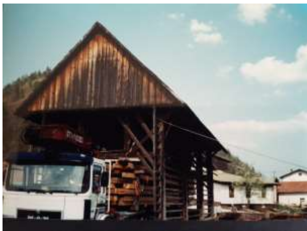
Die Verschiebung der Scheune
