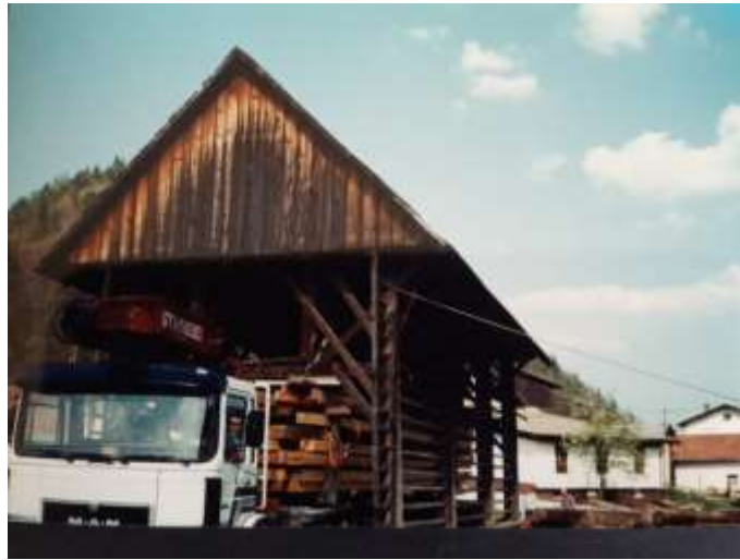
Die Verschiebung der Scheune
